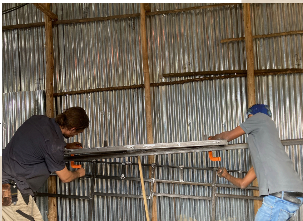
Photo d'Ambachew et Antoine réalisant la plateforme pour la protection d'une des églises.
